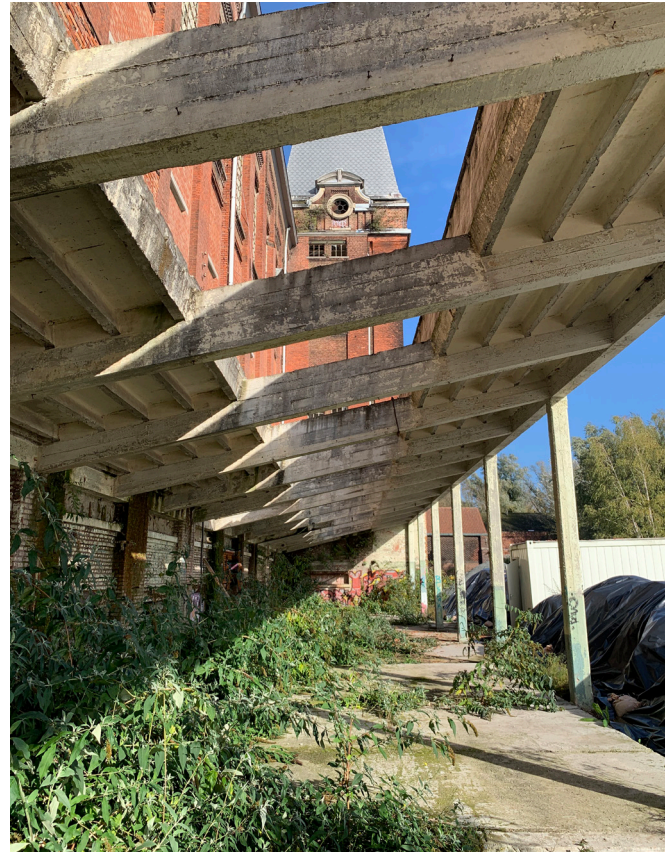
Foto aangebouwde luifels
