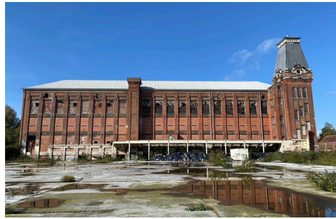
Foto historische gevel
