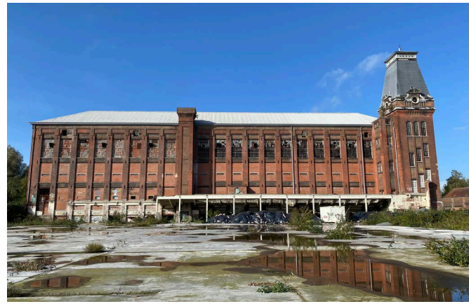
Foto historische gevel
