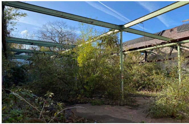
Foto bestaande structuur
